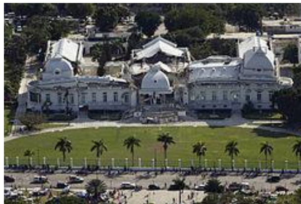
شکل ۱- نمونه وضعیت خرابی ابنیه در زلزله شهر پورتو پرنس، هائیتی.
