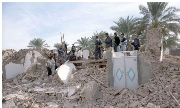
شکل ۲- وضعیت خرابی ساختمانهای خشت و گلی در زلزله شهر بم، ایران
