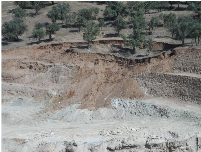
شکل ۲- زمین لغزش متراژ ۷+۲۶۰ در جاده دسترسی به کارگاه سد پارسیان [3].
